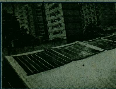
El sistema de calentamiento del agua consiste en colectores solares colocados sobre la cobertura liviana de la piscina. Estos colectores son como mantas de color negro que en su interior tienen un entramado de caños, en los cuales se calienta el agua por la acumulación de energía solar. Una pequeña bomba asegura la circulación de los 600 metros cúbicos del contenido de la piscina por el sistema.
